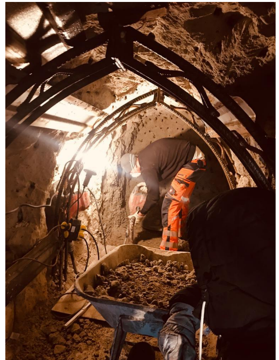
© BST – Stollen unter der Baumeisterstraße
