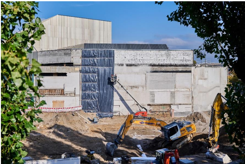
@Arno Kohlem – Abbruchwand, Rückwand Zuschauerraum KLEINES HAUS nach Abnahme Regiekabine
