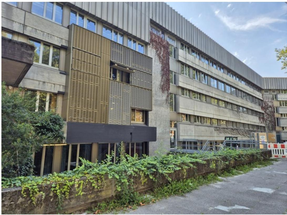
Die Musterfassade des neuen Badischen Staatstheaters ist montiert. Sie ermöglicht es Mechanik, Farbigkeit und weitere Details zu bemustern und zu diskutieren. In den vergangenen Wochen konnten offene Fragen der Detailplanungen geklärt werden.
